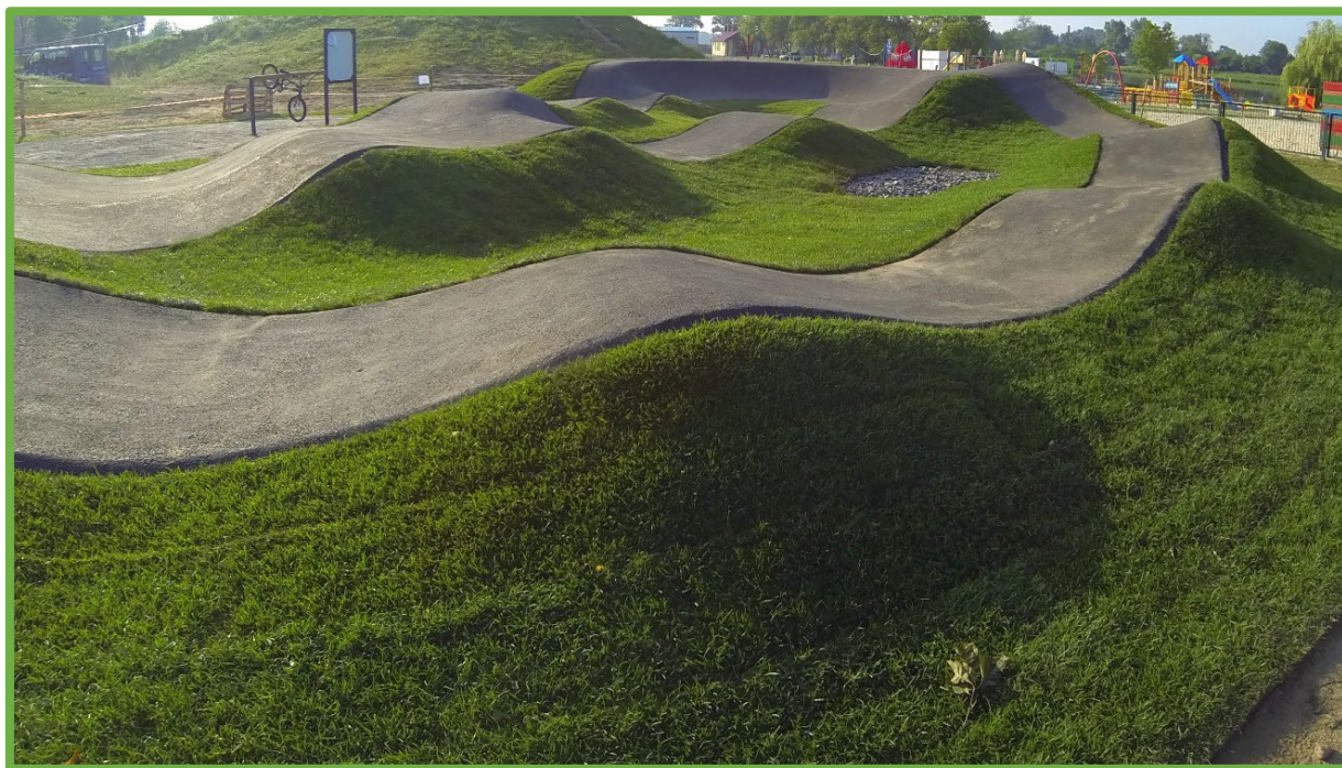
Ryc. 11. Garby o prawidłowo wyprofilowanych kształtach
