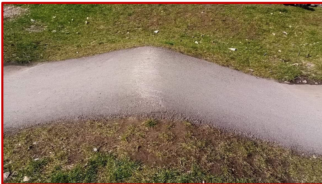
Ryc. 10. Niepoprawnie wyprofilowany garb – podjazd i zjazd płaski, szpiczasty kształt przeszkody
