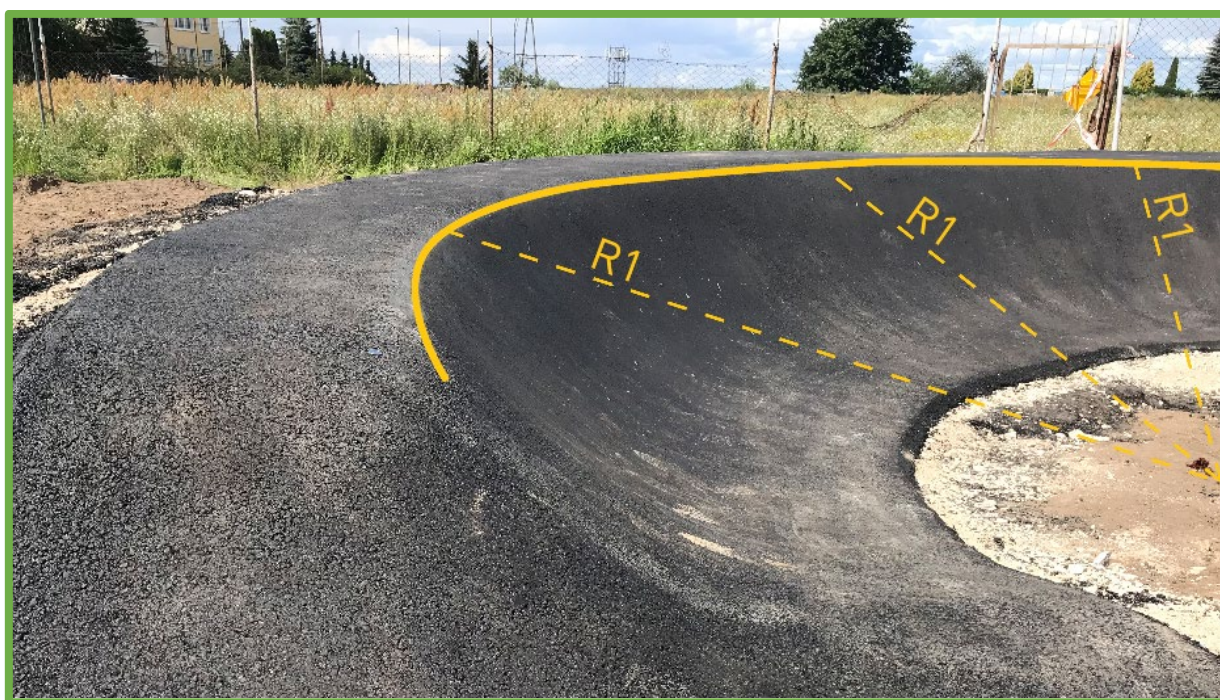
Ryc. 8. Prawidłowo wykonany zakręt profilowany – o jednostajnym promieniu zakrętu
