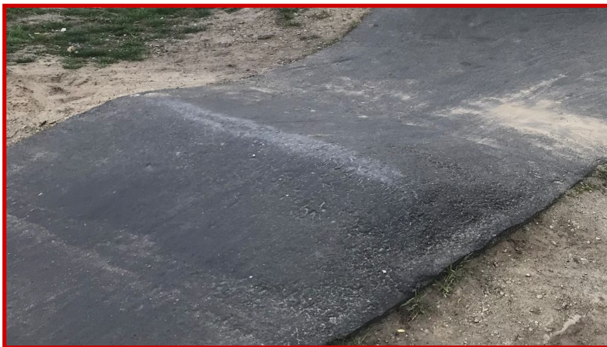
Ryc. 9. Niepoprawnie wykonany garb – o licznych nierównościach i złym kształcie
