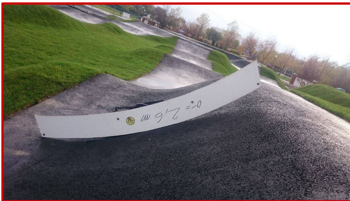
Ryc. 5. Nieprawidłowo wykonany zakręt profilowany, którego przekrój nie stanowi wycinka koła.
