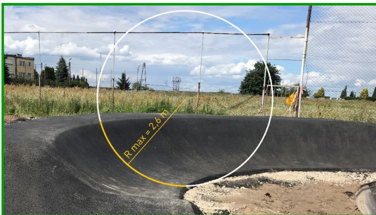
Ryc. 6. Prawidłowo wykonany zakręt profilowany, którego przekrój stanowi wycinek koła.
