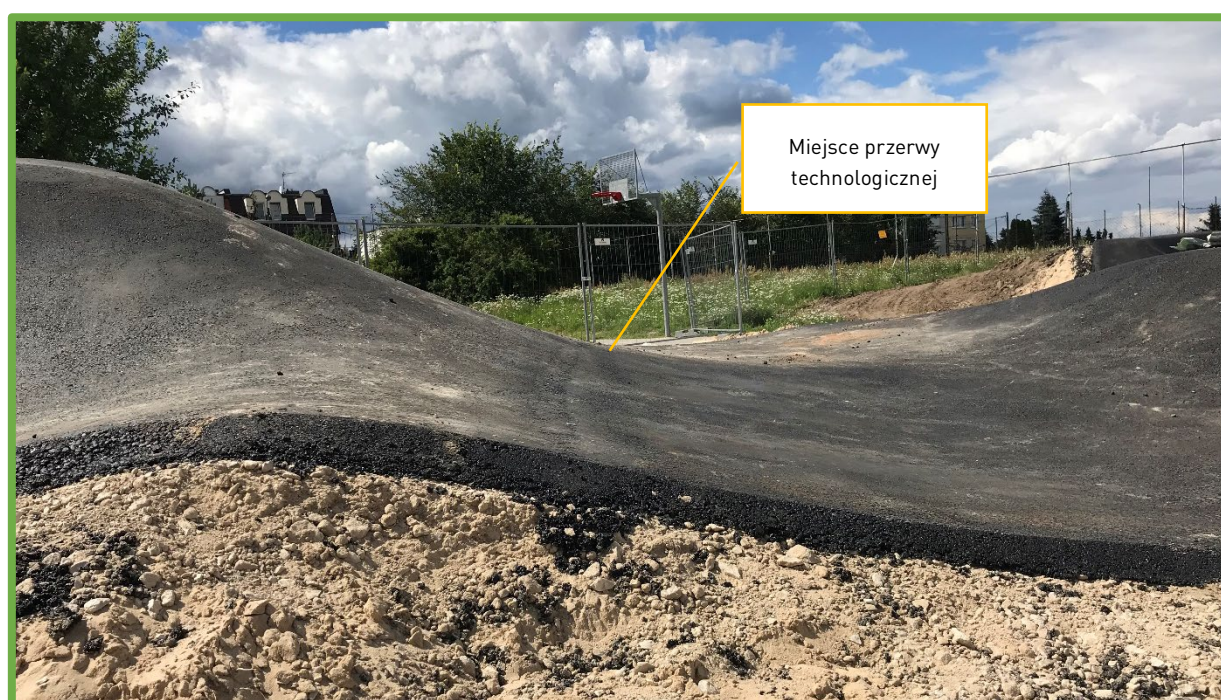
Ryc. 4. Prawidłowo wykonane połączenia – bez wyczuwalnych uskoków ani zmian profilu przeszkody.
