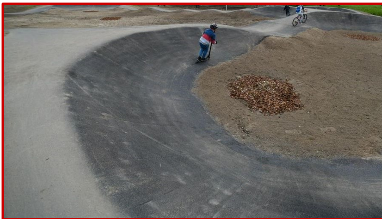
Ryc. 7. Nieprawidłowo wykonany zakręt o niejednostajnym promieniu, bez wyprofilowanej dolnej półki oraz niebędący w przekroju wycinkiem koła.
