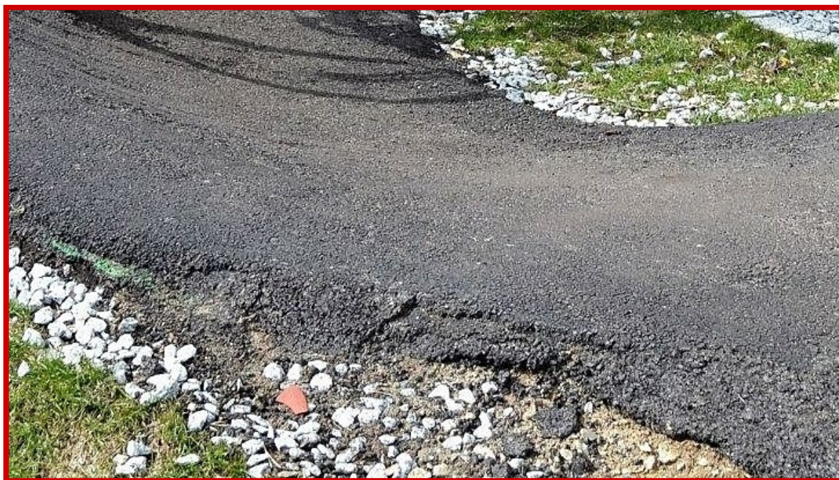
Ryc. 2. Nieprawidłowe wykończenie krawędzi nawierzchni jezdnej – nierówne, bez fazowania, z ubytkami.
